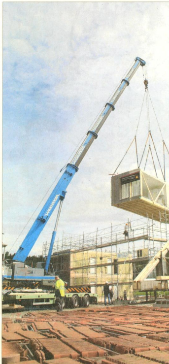
Bald fehlen nur noch die Ziegel auf dem Dach: Mit absoluter Präzision Kranführer die einzelnen Module zu zwei Häusern zusammen. (snk)
