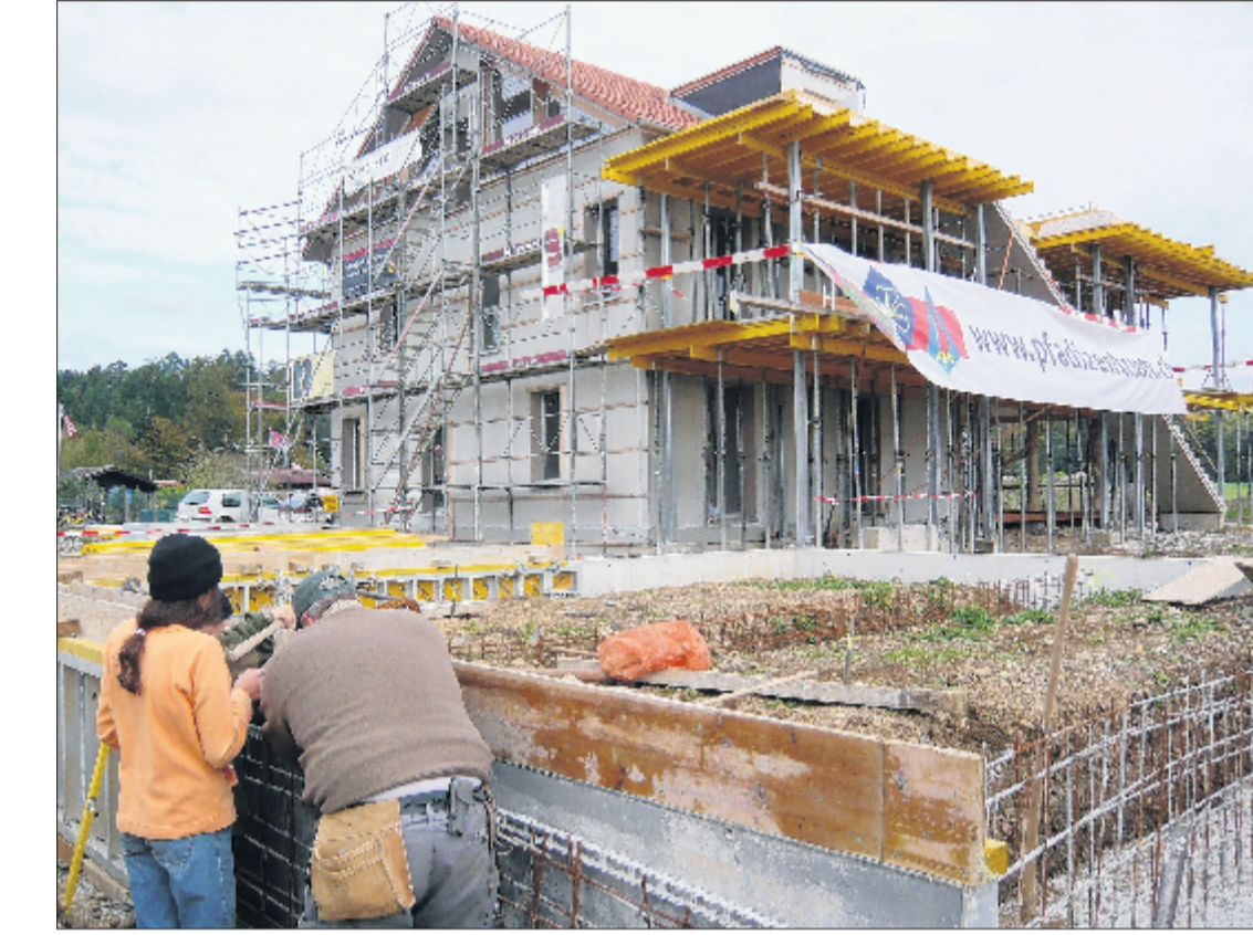
Während Baugeschäftsinhaber und Pfadfinder-Vater Patrick Utzinger den beiden Pfadern Sungari (links) und Odin erklärt, wie man die Verschalung beim Fundament fürs zweite Haus korrekt anbringt, ist Pfadi-Leiter Geko alias Markus Kohl derweil mit dem Innenausbau des bereits fast fertigen ersten Hauses beschäftigt. (Bilder: thi)
